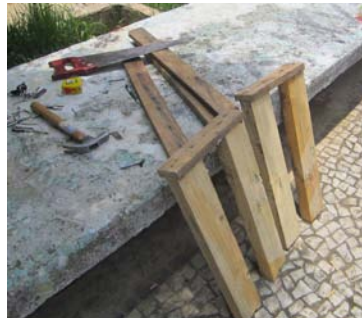
Montagem das partes do banco
